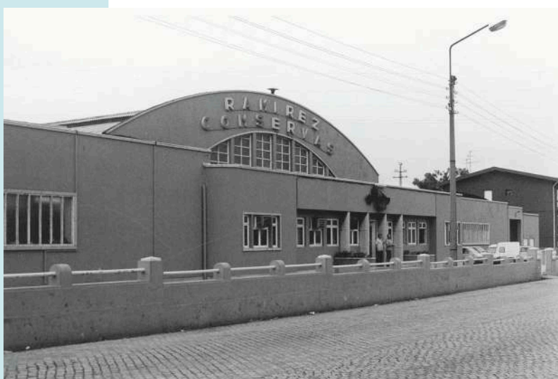
Fábrica Ramirez. Fonte: AFCMM.
